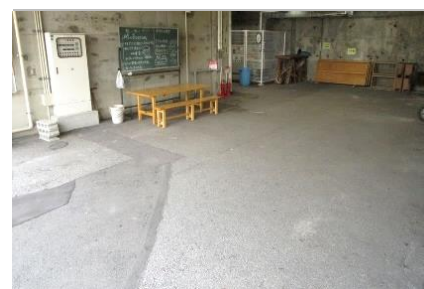
ガレージ (約50人) 屋根のある屋外スペース。 調理、工作、レクリエーションなど。
